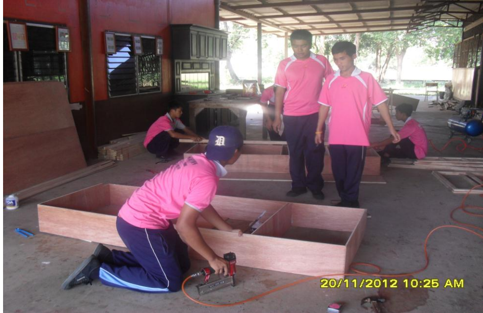
ภาพที่ 9 กำลังยิงโครง
