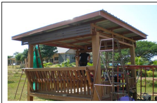
ภาพที่ 35 การติดไม้ระแนง
