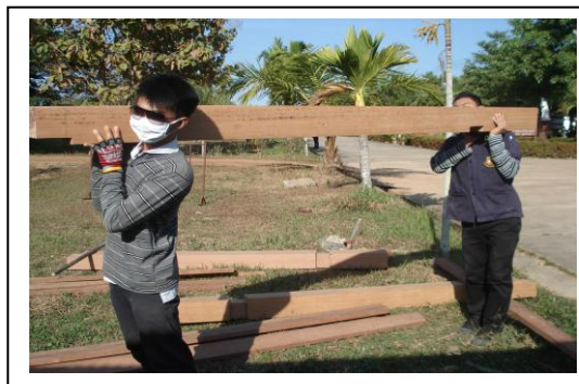
ภาพที่ 17 การนำเสามาประกอบ
