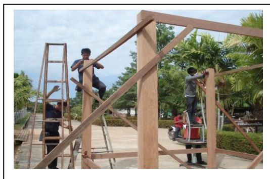
ภาพที่ 21 การตั้งเสา
