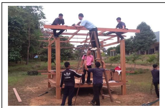
ภาพที่ 31 การยิงไม้ระแนง
