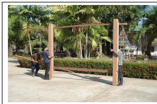
ภาพที่ 21 การตั้งเสา
