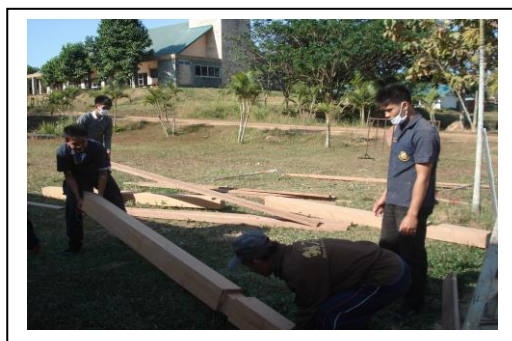
ภาพที่ 19 การประกอบเสา
