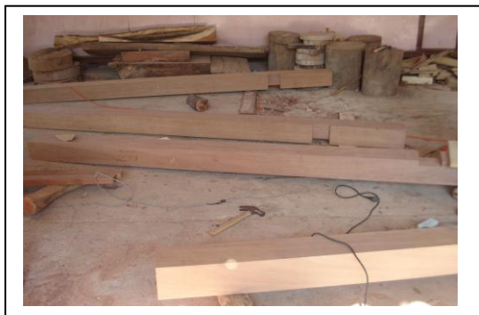
ภาพที่ 16 การเตรียมเสา
