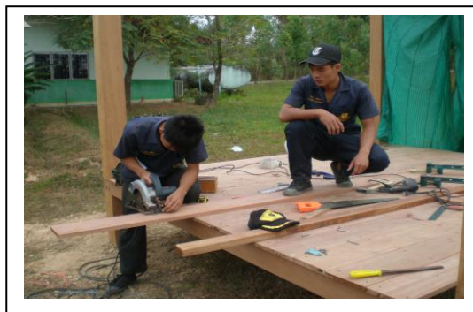
ภาพที่ 29 การตัดไม้พื้น
