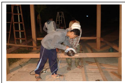
ภาพที่ 27 การตัดคาน
