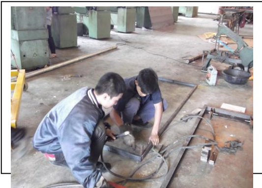
ภาพที่ 7 เชื่อมฐานบนลิฟท์
