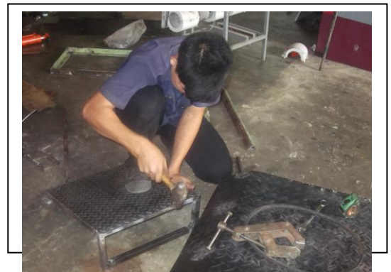
ภาพที่ 24 ซ่อมบำรุงทางขึ้นลิฟท์
