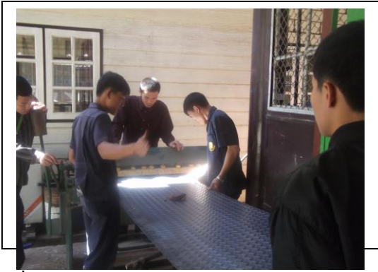
ภาพที่ 9 เตรียมกับเหล็กแผ่นลาย
