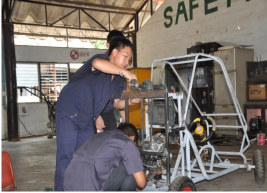
รูปที่27 ทำการติดตั้งแกนใบพัด
