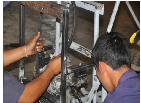
รูปที่24 กำลังติดตั้งสายพาน
