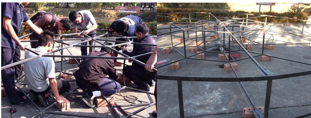
รูปที่ 19 พอเชื่อมเสร็จแล้วก็ออกมาเป็น โครงกึ่งหัน
