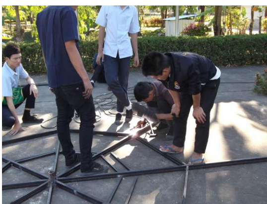
รูปที่ 14 การเชื่อมโครงกั้น ชุดที่สอง
