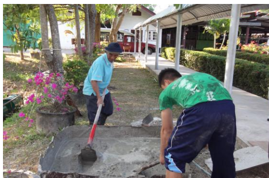
รูปที่ 22 การผสมปูนเพื่อที่จะนำไปเทเสา
