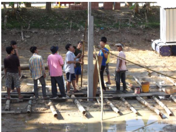
รูปที่ 25 การตั้งเสา
