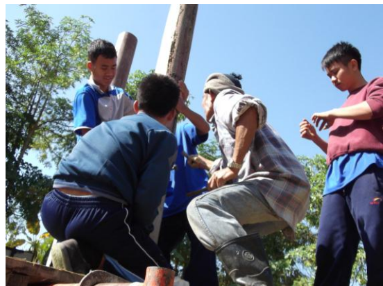
รูปที่ 28 การต่อเสาไม้กับเสาปูนเข้าด้วยกัน
