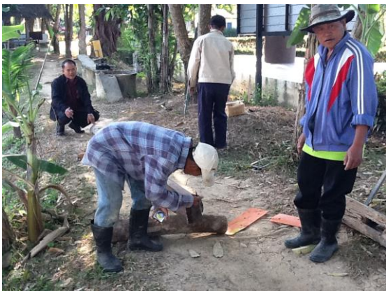
รูปที่ 27 การตัดไม้เพื่อที่จะไปต่อเสา
