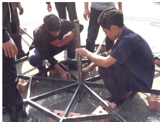
รูปที่ 17 นำท่อแป๊บมาสอดใส่ตรงการเพื่อที่จะยกขึ้นแล้ว จะได้ ตรงกัน
