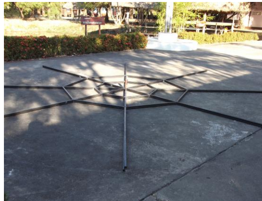
รูปที่ 15 โครงที่เชื่อมเสร็จ
