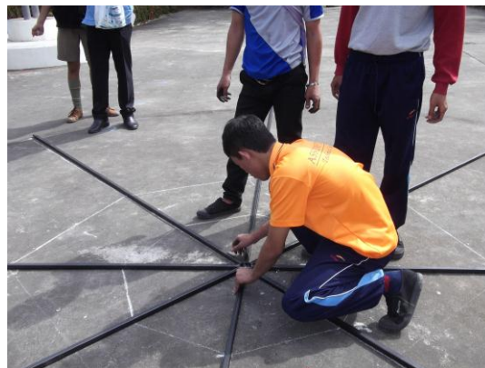
รูปที่ 11 นำเหล็กไปวางไว้กับแบบที่วาดขึ้น
