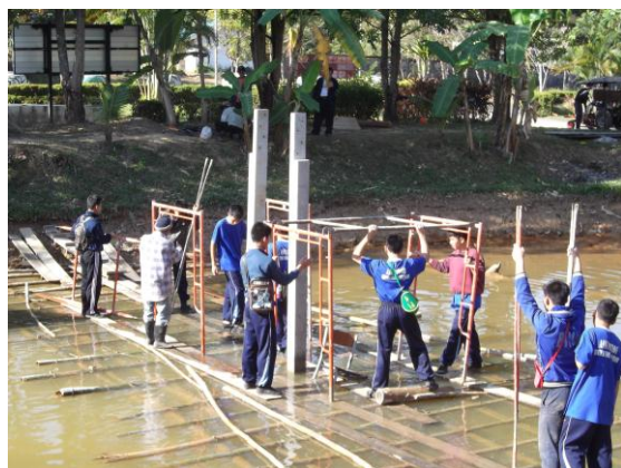
รูปที่ 26 การตั้งนั่งร้าน
