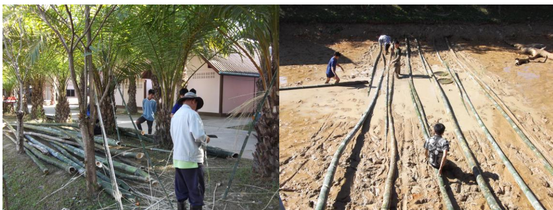
รูปที่ 21 นำไม้ไผ่มาเพื่อที่จะประกอบทำเป็นแพเพื่อที่เดินลงไปทำงานได้สะดวก
