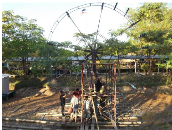
รูปที่ 33 การติดตั้งใบกังหัน
