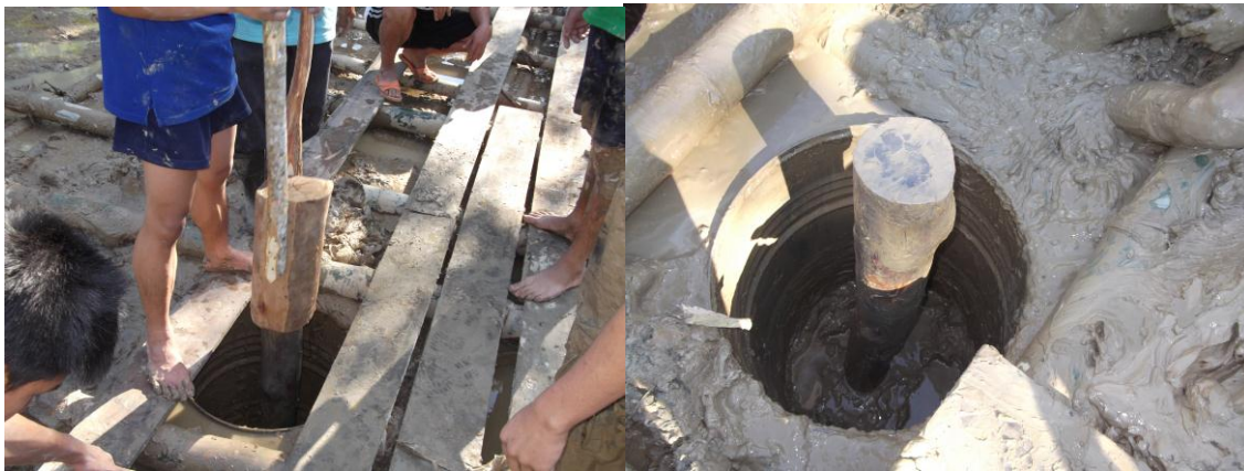
รูปที่ 23 การตอกเสาะเข็ม
