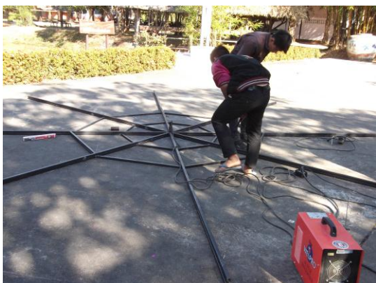
รูปที่ 12 ประกอบเสร็จแล้วเชื่อมต่อกัน
