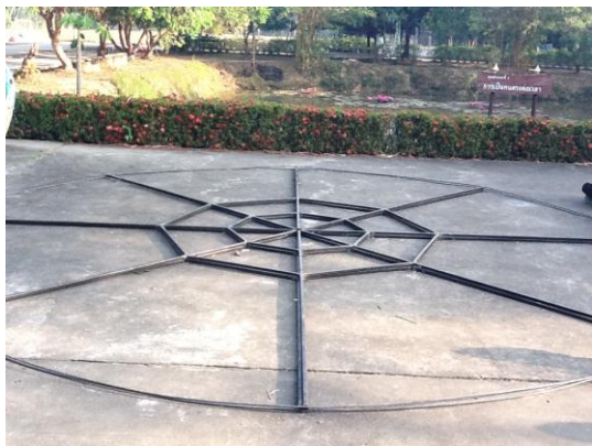
รูปที่ 16 นำเหล็กเส้นมาเชื่อม โครงด้านนอก
