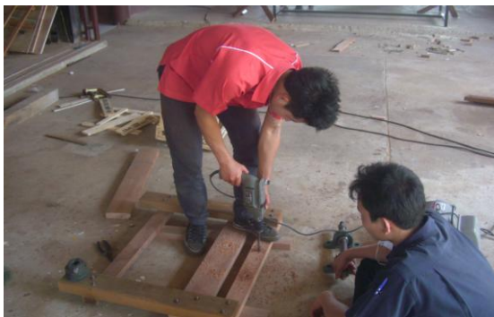
ภาพที่3.การเจาะรูติดตั้งมอเตอร์
