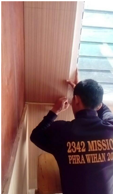
ภาพที่ 31 ปิดผนังด้วยไม้อัดสัก
