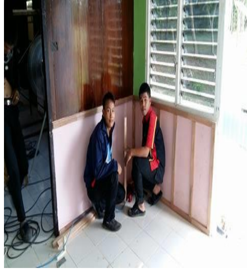
ภาพที่ 26 ทำแผงไม้เพื่อยิงไม้อัด
