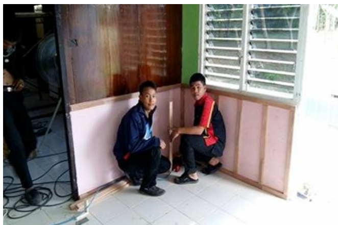
ภาพที่ 19 ประกอบไม้อัดเข้ากับผนัง
