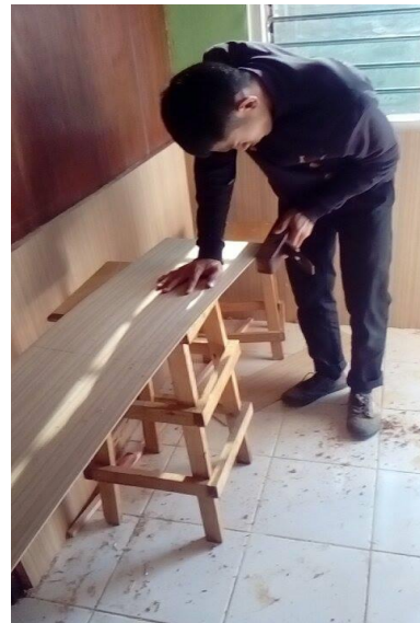
ภาพที่ 32 ตัดไม้อัดสักเพื่อปิดฝาผนัง
