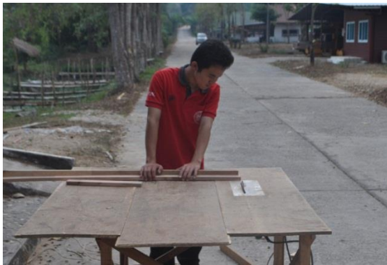
รูปภาพที่ 32 การตัดไม้โครงเพื่อเสริมผนัง
