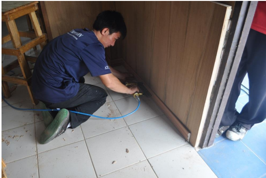
รูปภาพที่ 27 การตัดบัวพื้น
