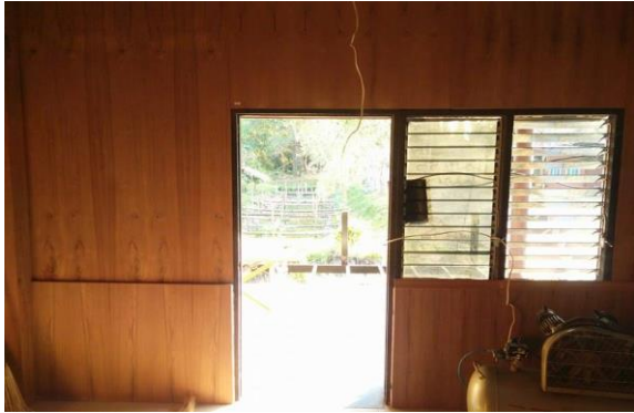
รูปภาพที่ 34 ผนังห้องหลังติดไม้อัดใส่ผนังเดิมแล้ว
