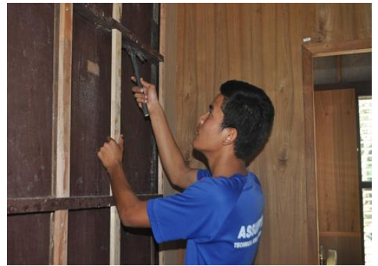
รูปภาพที่ 33 การเสริมไม้โครง
