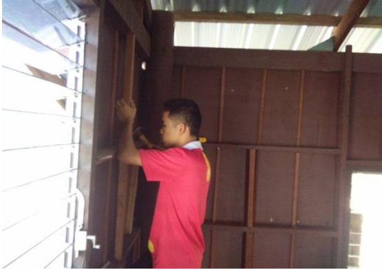
รูปภาพที่ 30 การเสริมโครงผนัง
