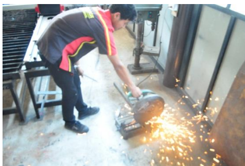
รูปภาพที่ 20 นำเหล็กมาวัดและตัดขนาด35ซม 60ซมและตัดเหล็ก2*2นิ้วให้ได้80ซม
