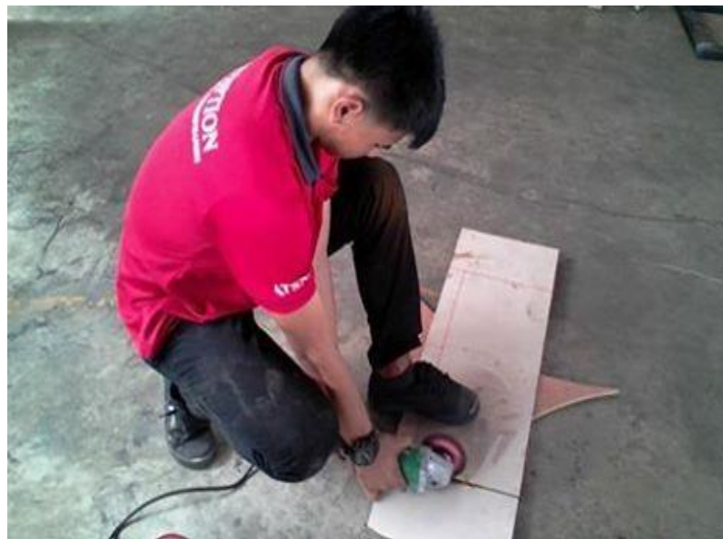
ภาพที่ 6 ตัดแผ่นไม้ยึดกับฐาน
