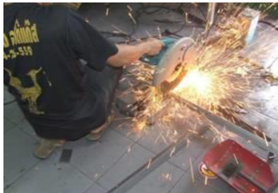
ภาพที่ 20 การตัดเหล็ก
