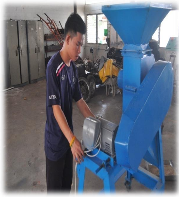
ภาพที่ 37 การติดตั้งมอเตอร์ไฟฟ้า
