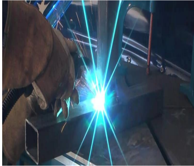
ภาพที่ 21 การเชื่อมโครงสร้าง
