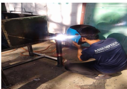
ภาพที่ 12 ทำงานเชื่อมโครงสร้าง
