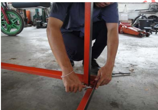
ภาพที่ 10 การยึดล้อติดกับ โครงสร้าง
