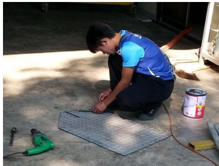
ภาพที่ 13 การวัดและตัดแผ่นสแตนเลส
