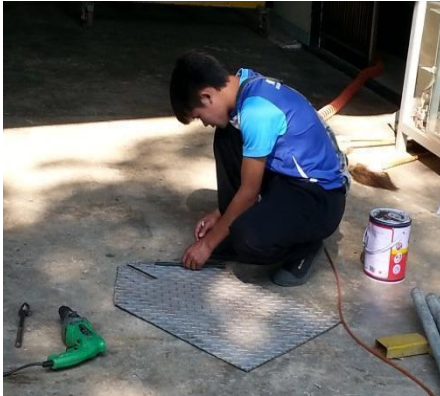
ภาพที่ 18 ตัดแผ่นสแตนเลส
