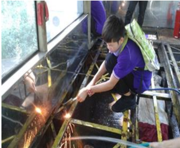
รูปภาพที่ 9 แสดงการตัด โลหะด้วยแก๊ส
