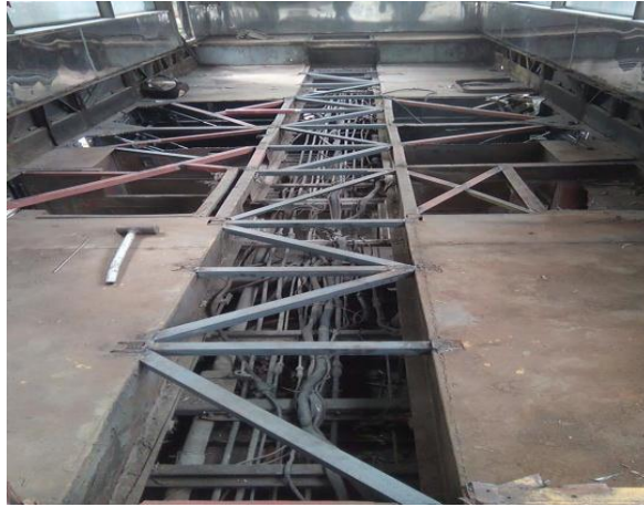
รูปภาพที่ 13 การเชื่อมปิดร่องพื้น เพื่อนำมาปูเหล็กแผ่นลาย
