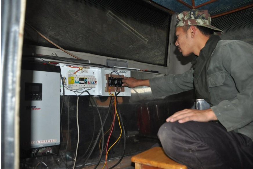
ภาพที่ 8 ติดตั้งระบบไฟต่างๆ
