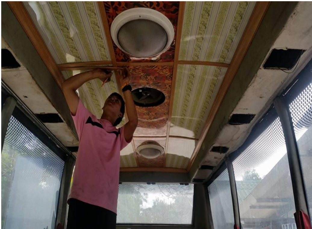
รูปภาพที่ 43 การติดฝา การติดบัว
