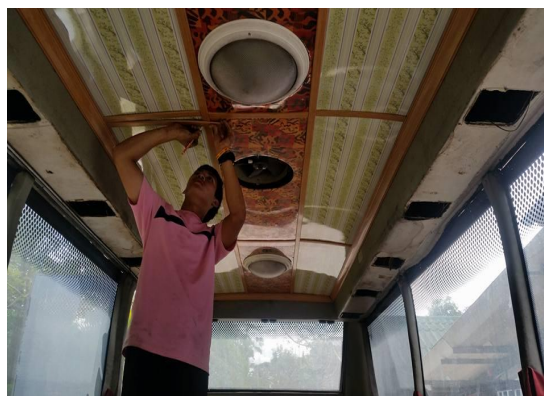
รูปภาพที่ 32 ติดเพดานและติดบัว
