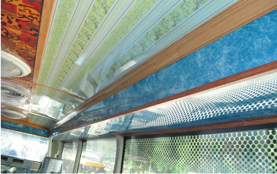
รูปภาพที่ 44 ภาพหลังจากการติดฝาและติดบัว
