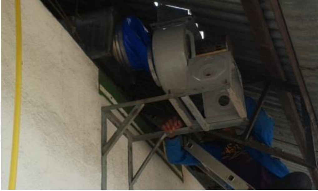
รูปภาพที่ 19 การติดตั้งพัดลมหยอโข่ง
