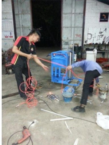
ภาพที่ 21 เดินสายลมไปยังอุปกรณ์
