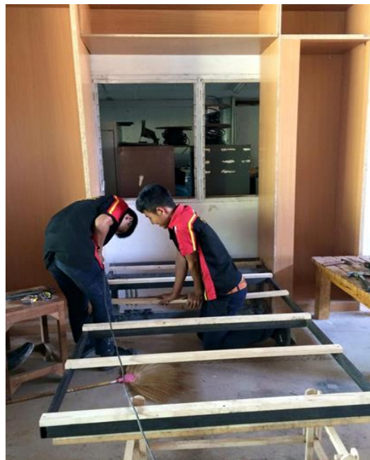
ภาพที่ 36 กำลังนำไม้มายิงรองรับเตียง
