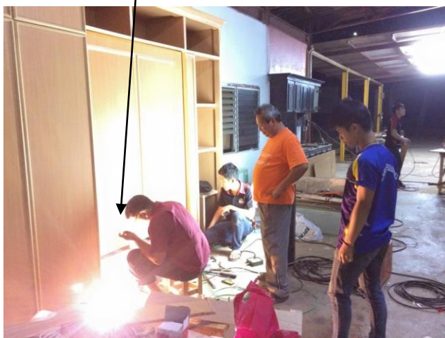
ภาพที่ 31 เชื่อมโครงตัวยึดสปริง
