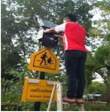
ภาพที่ 15 ทำการติดตั้งเดินไฟ
