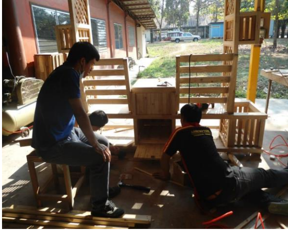
ภาพที่ 34 ทำโครงสร้าง
