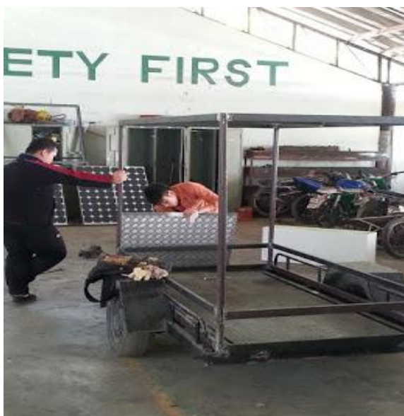
ภาพที่21 การติดตั้งแผงหน้า
