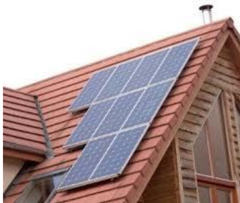
ภาพที่ 17 การติดตั้งแผงโซลาร์เซลล์
