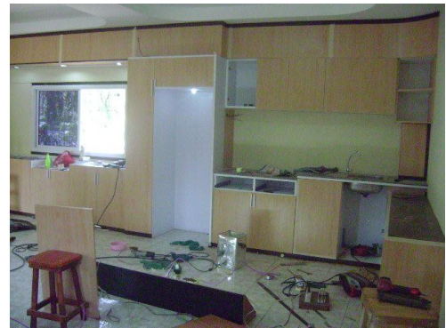
รูปภาพที่ 25 ติดตั้งและตกแต่งสี
