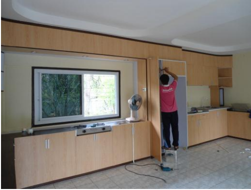
ภาพที่ 33 ติดตั้งมือจับ
