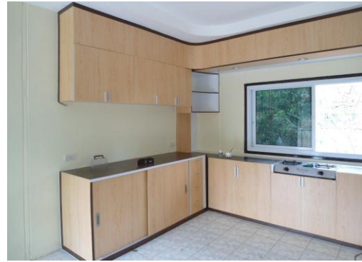
ภาพที่ 34 เสร็จสมบูรณ์
