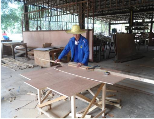
ภาพที่ 21 กำลังตัดไม้โครงเพื่อจะมายิงแผง
