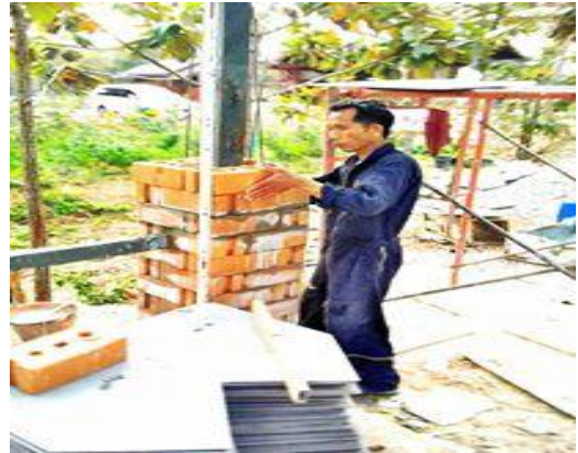
ภาพที่ 14 ก่อเสา
