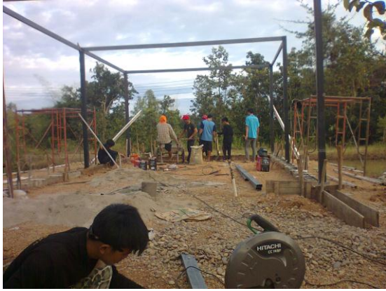
ภาพที่ 7 ตั้งเสาเทคอน
