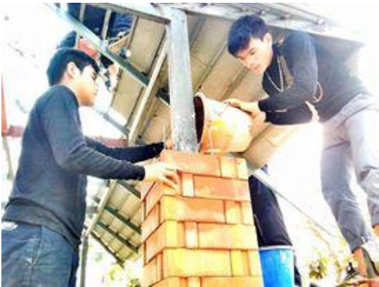
ภาพที่ 13 ก่อเสา
