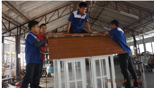
ภาพที่ 8 ติดตั้งมุงหลังคา
