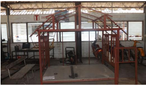
ภาพที่ 5 ขึ้นโครงติดตั้งเรียบร้อยแล้ว
