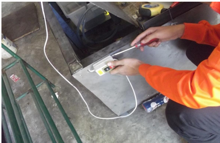
ภาพที่ 5 ทำการต่อระบบไฟ
