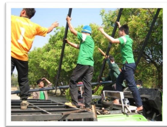
ภาพที่ 12 ประกอบโครงหลังคา
