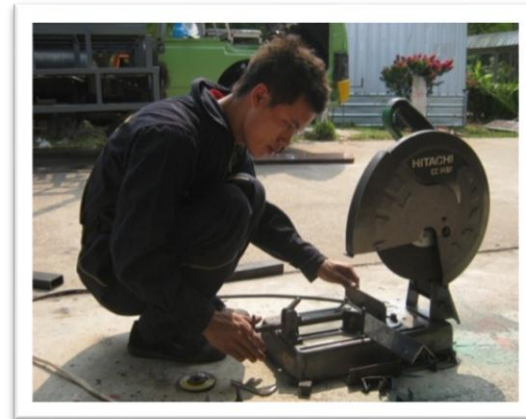
ภาพที่ 10 ทำโครงสร้าง
