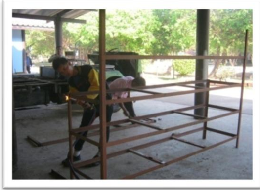
ภาพที่ 8 ทำโครงสร้าง
