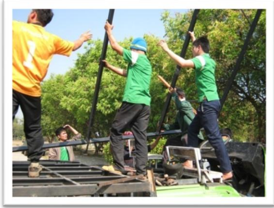
ภาพที่ 6 ยกโครงหลังคาขึ้นรถ
