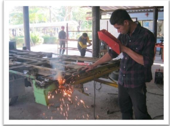
ภาพที่ 3 ทำโครงสร้างตัดเหล็ก
